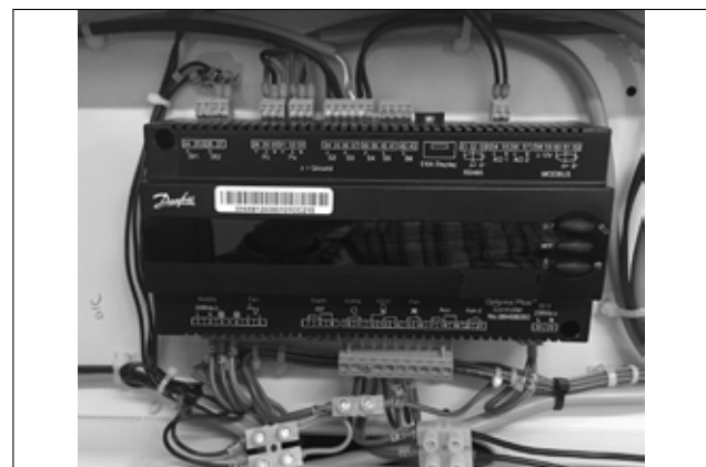
Bild 5: Tillfälliga anslutningar
