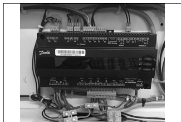
Billede 5: Midlertidig ledningsføring
