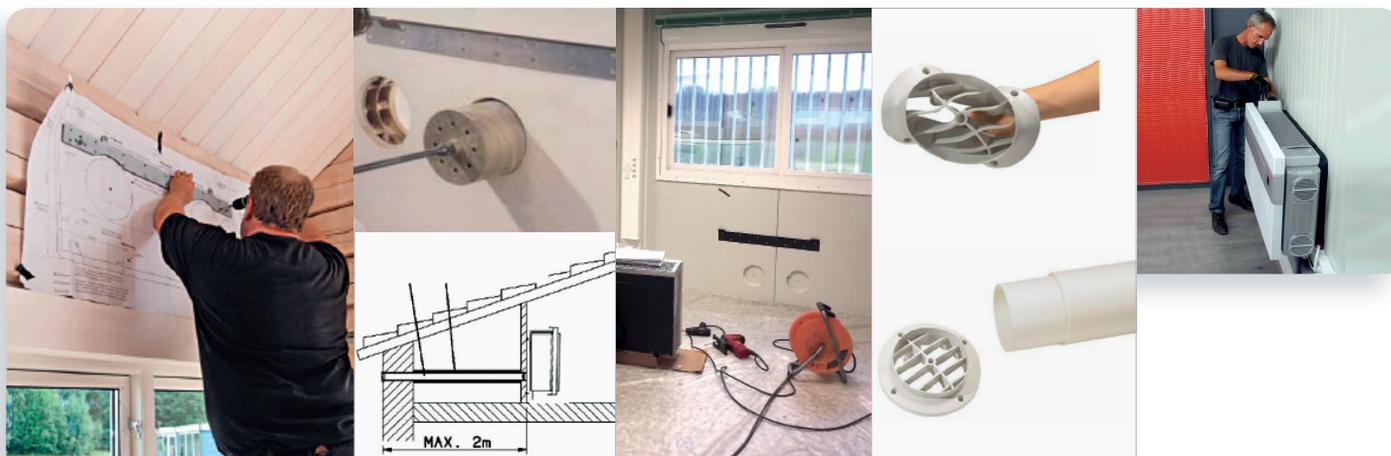
Ce type de pompe à chaleur, de part sa conception, ne nécessite pas l'intervention d'un technicien spécialisé détenant la certification F-gas. Pour installer les pompes à chaleur, commencer par faire 2 trous dans le mur à l'aide du gabarit papier (fourni). Suivez ensuite la procédure d'installation décrite dans la notice de montage.
